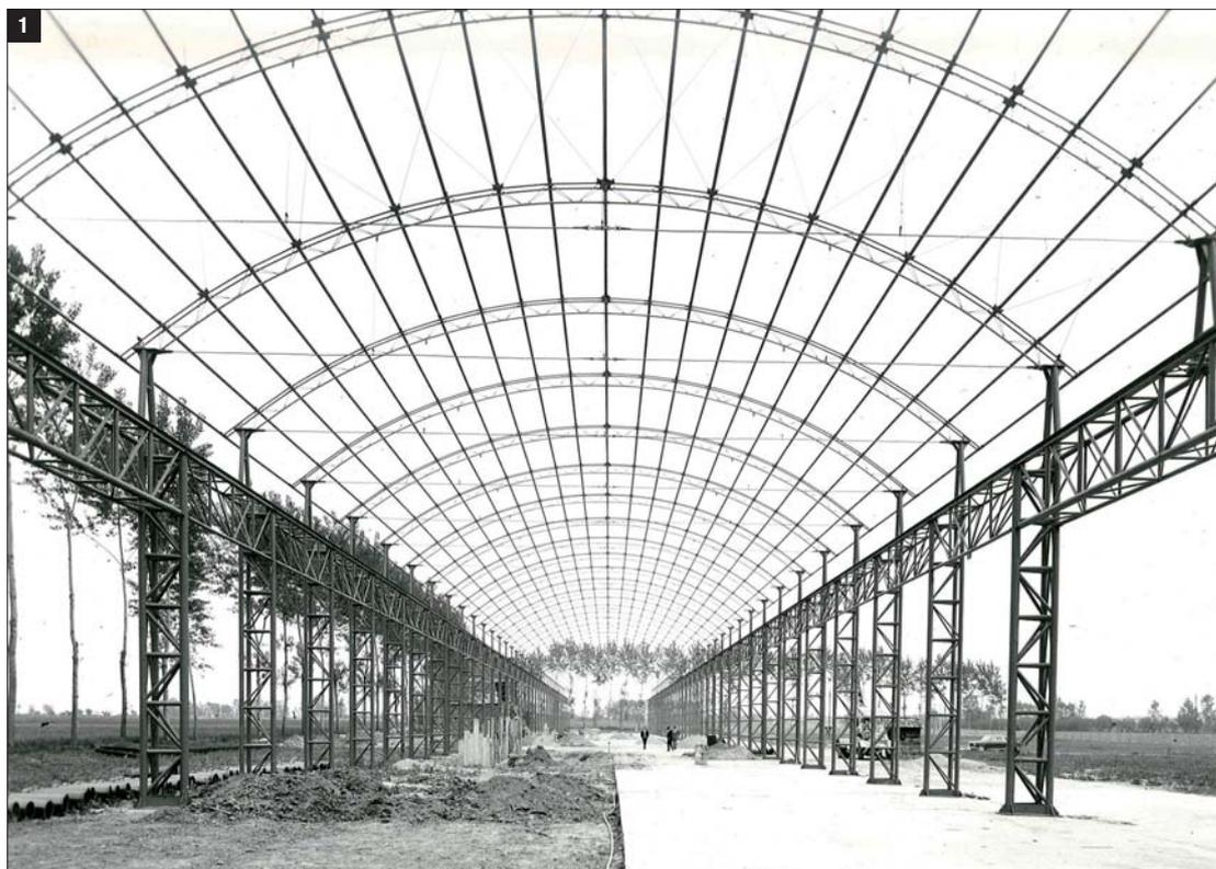
Fig. 1 – Capannone n. 1 in costruzione.
